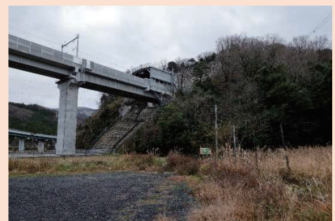
▲中池見湿原の脇に建設された深山トンネル
